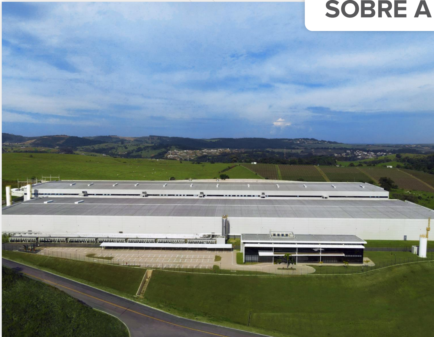
Campus de Data Center e sede administrativa em Vinhedo, São Paulo
